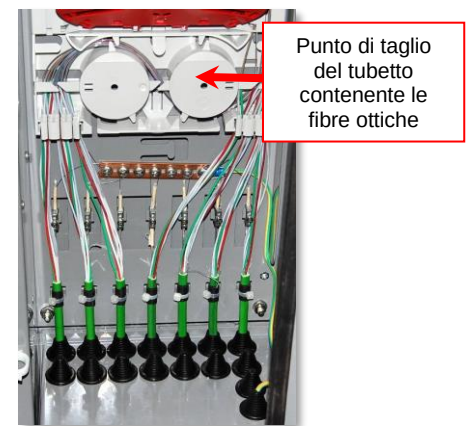
Figura 12: PREDISPOSIZIONE DEI CAVI OTTICI DI RETE
