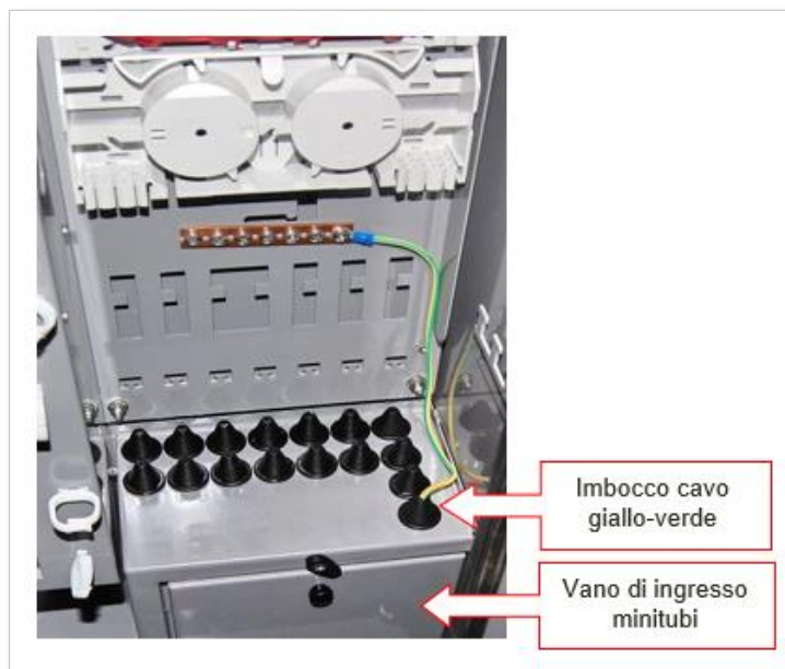
Figura 31: COLLEGAMENTO EQUIPOTENZIALE DELLA STRUTTURA METALLICA DELL'ARMADIO
