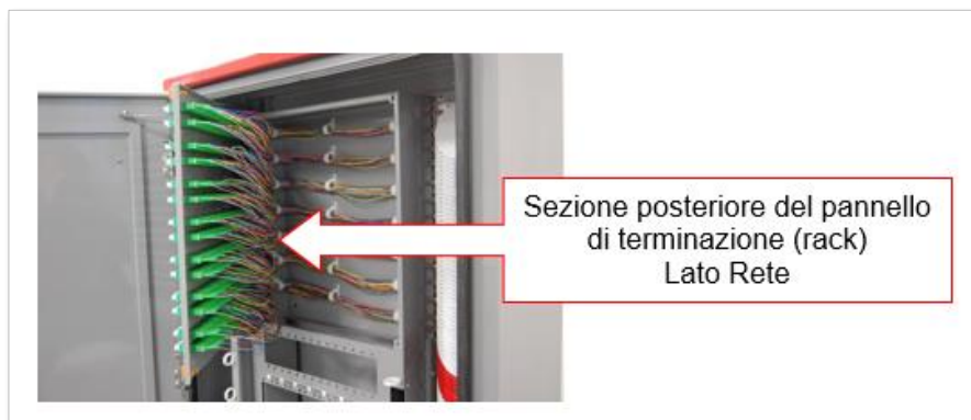
Figura 24: PREDISPOSIZIONE DEI CABLAGGI SUL PANNELLO DI TERMINAZIONE LATO RETE
