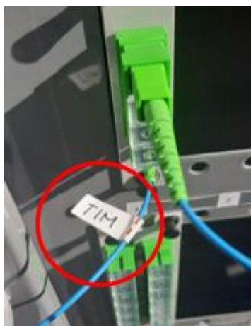
Figura 35: ESEMPIO DI IDENTIFICAZIONE OPERATORE UTILIZZATORE DELLO SPLITTER
