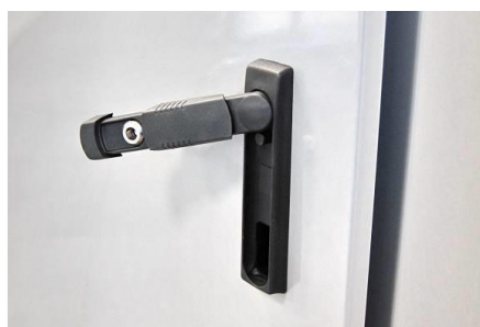
Figura 3: DETTAGLIO DEL SISTEMA DI SEGREGAZIONE DELL'ARMADIO OTTICO
